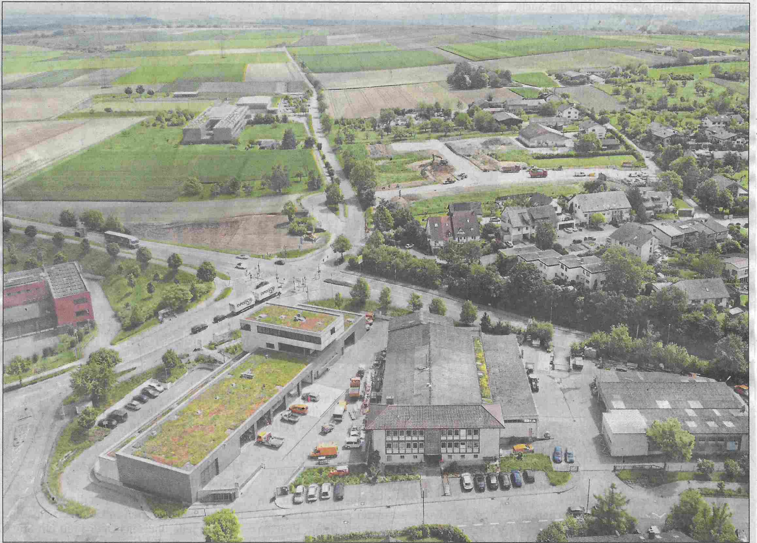
Das technische Rathaus (vorne) und das Stromberg-Gymnasium (links hinten) gehören zu frühen Ausbaustufen des Nahwärmenetzes. Foto: Küppers
