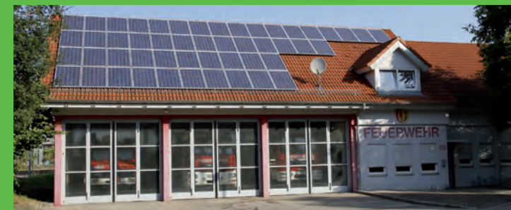
Feuerwehrgerätehaus Enzweihingen: 12 kWp
